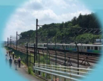
西武線 車両基地
